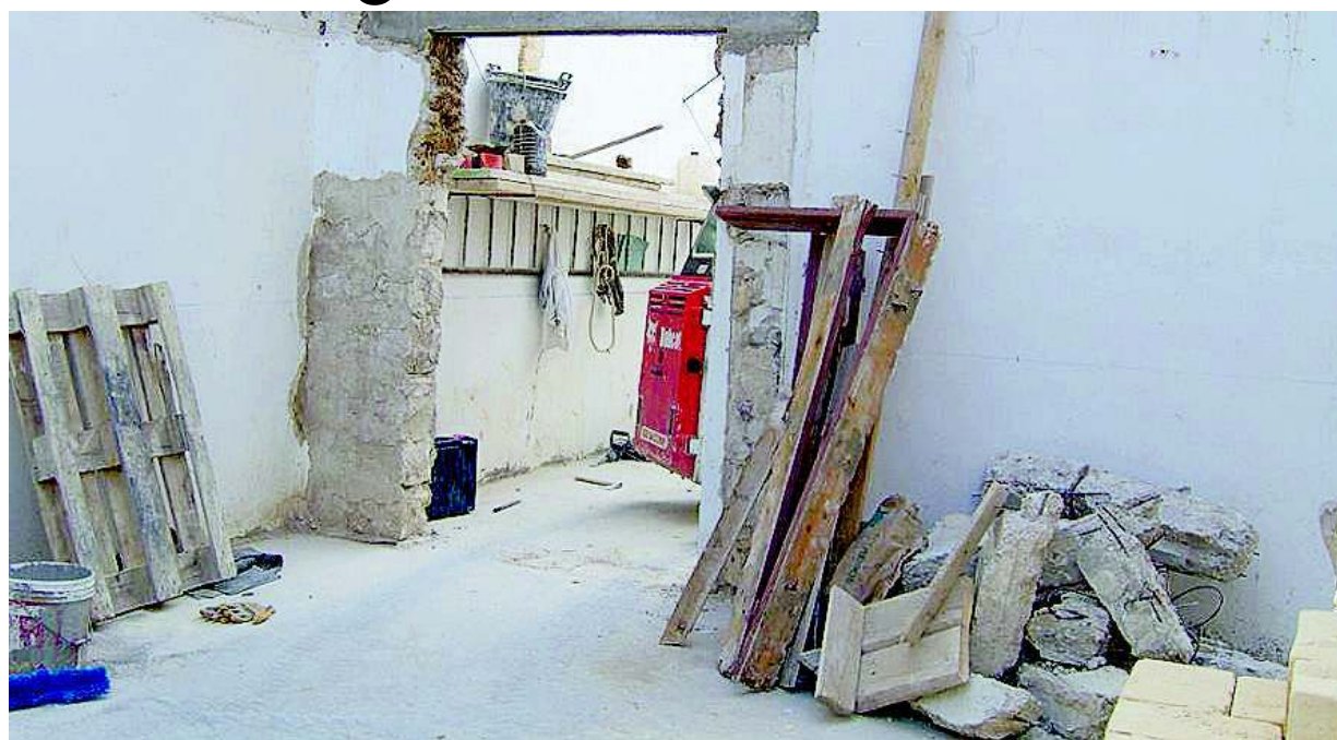
>>> Un immobile in via di ristrutturazione
